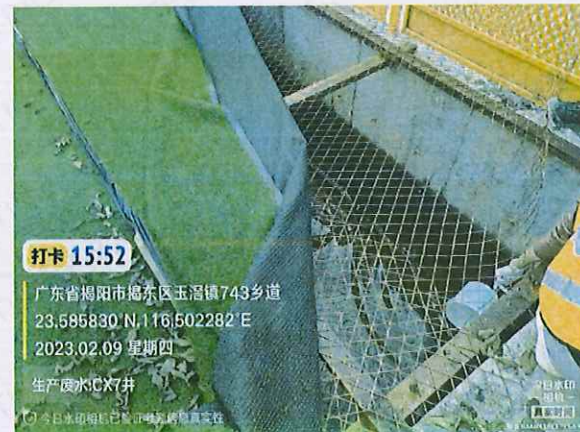
施工 2 标 CX7#施工废水沉淀池末端
