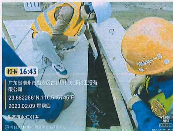
施工 1 标 CX1#施工废水沉淀池出口
